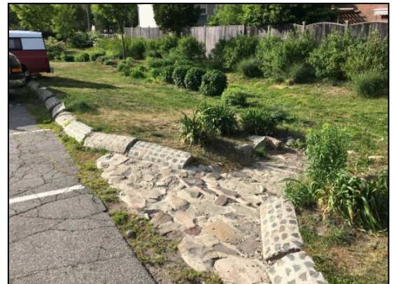
Ejemplo de una infraestructura de aguas pluviales ecológica
